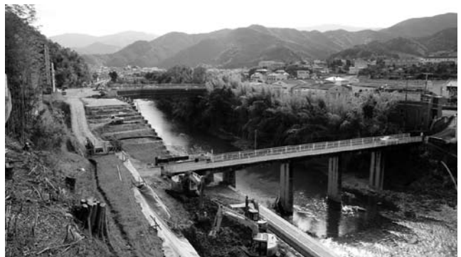
町道平中通り2号線〔仮称・新龍光寺橋〕上部工事(動木) 手前は今月より撤去工事が始まる龍光寺橋
