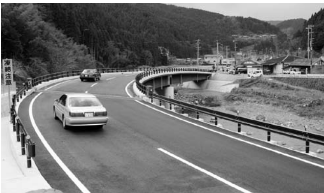
完成した国道370号「小西工区」バイパス部(小西)
