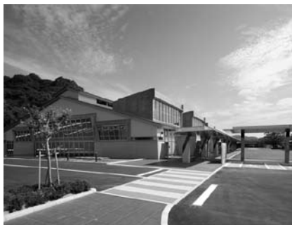
増築工事が完成した五色台聖苑
