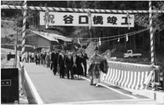
谷口橋竣工 (4/16・長谷宮地区)
