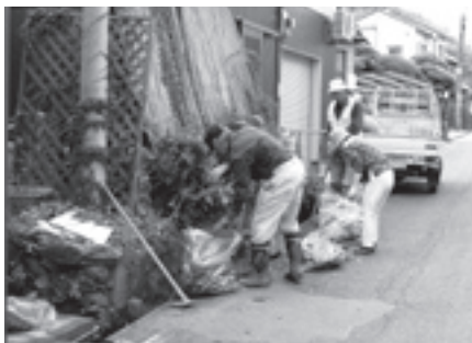
側溝の清掃をする住民の皆さん(動木地区)
