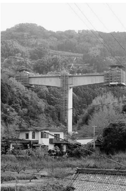
橋梁工事が進む山畑2期地区 基幹農道(動木)
