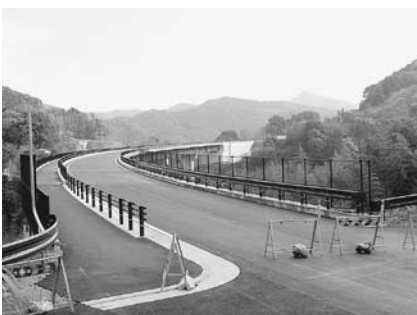
橋梁工事が完成した国道370号(橋下)
