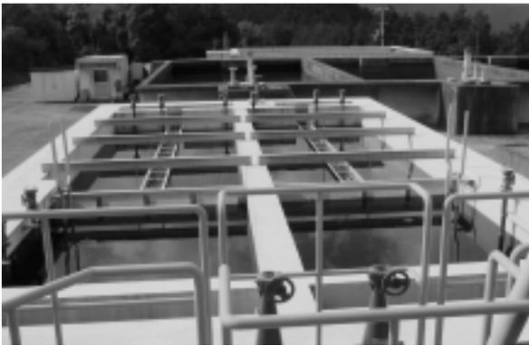
松ヶ峯浄水場の改良された沈殿池(手前)と1池増設されたろ過池(前方)
