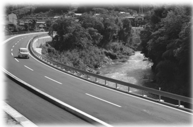
平成 27 年に開通した国道 370 号(小畑～下佐々間)
