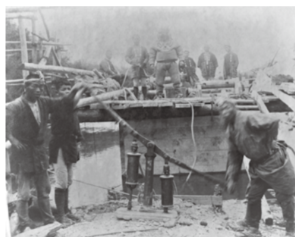
(亀池 揚水工事と潜水夫)
