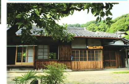
田舎生活体験施設 木市
