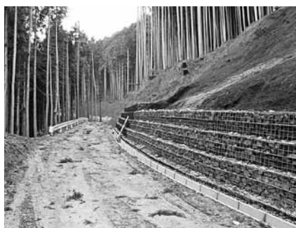
林道毛原下滝ノ川線（滝ノ川地区）
