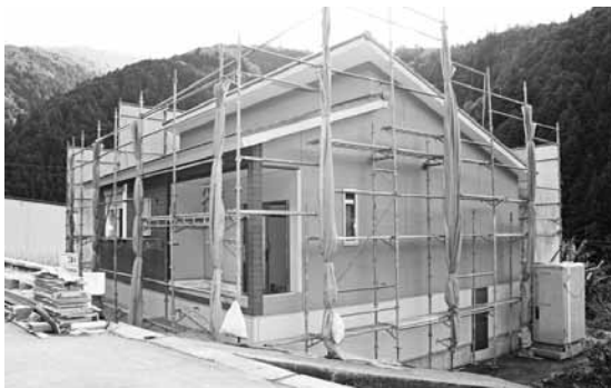
建設中の毛原上集会所
