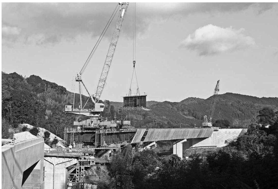
橋梁工事が進む国道370号（樋下地区）
