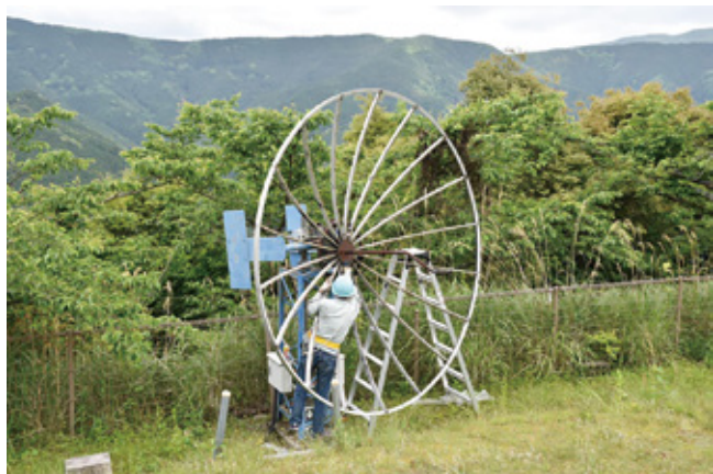
写真：3m電波望遠鏡解体作業
