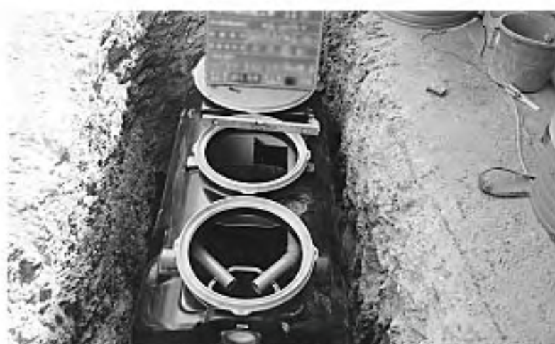
合併処理浄化槽の設置
