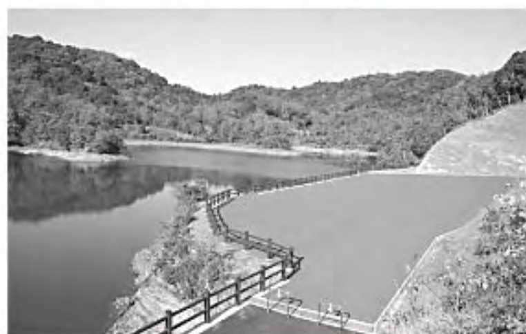
完成した桧河池周辺整備工事
