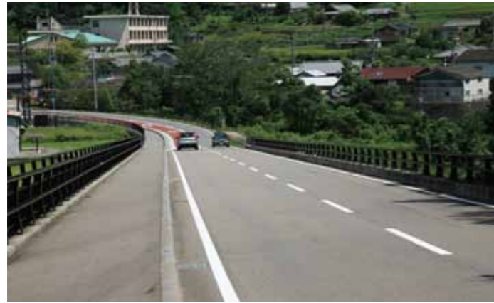
(毛原宮地内・毛原大橋付近)
