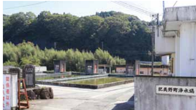
紀美野町浄水場
