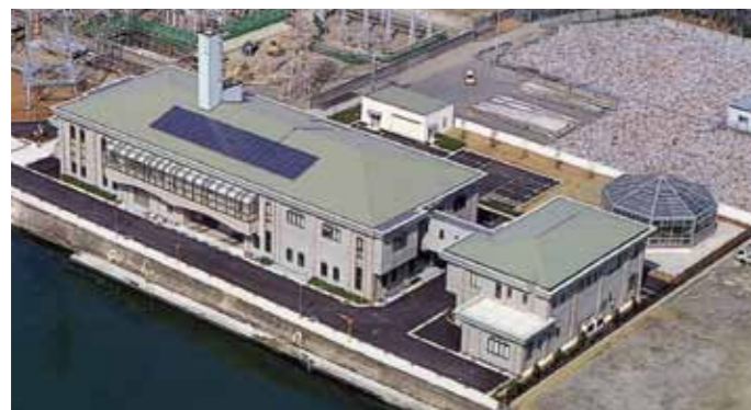
海南海草環境衛生センター (し尿処理場)
