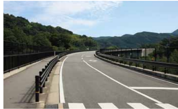
(樋下地内・大原大橋付近)
