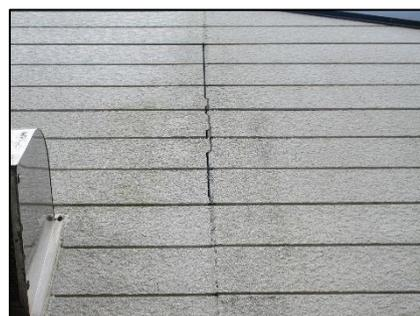
外壁目地シーリングの破断
