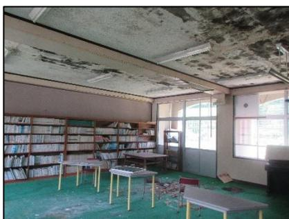
天井の雨漏れ・漏水
