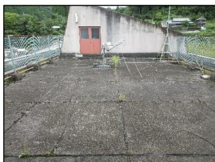
アスファルト保護防水の亀裂
