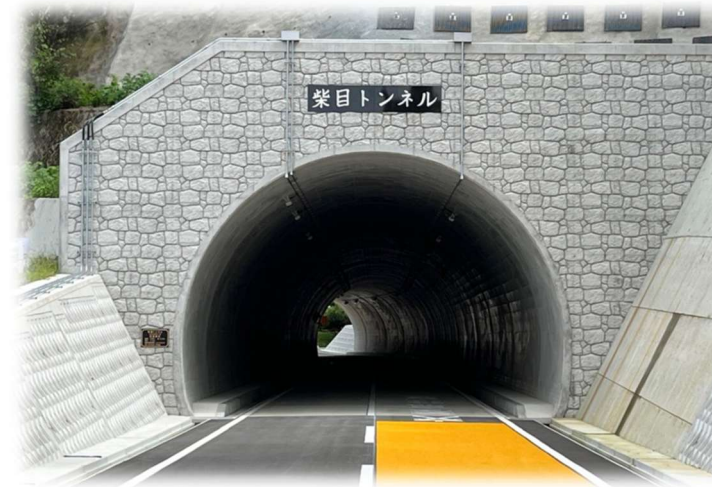
柴目トンネル
